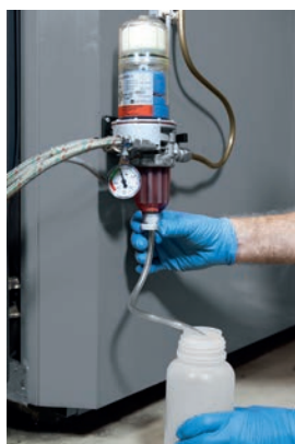
Vidange de la tasse avant son démontage
