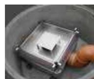
◀ Filtre dégrilleur VF12 vendu seul, installé dans regard béton.
